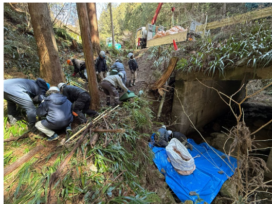
撤去作業(長沢地区)
