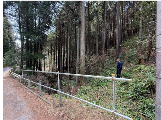
撤去後(長沢地区)
