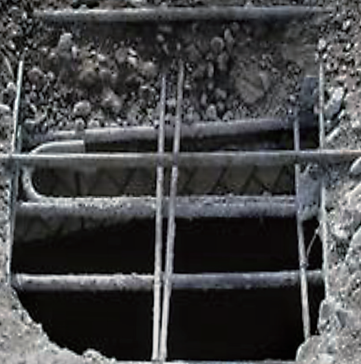
※写真は、橋梁のコンクリート床版の損傷事例
