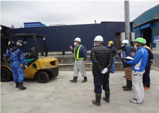
現場巡視の様子
