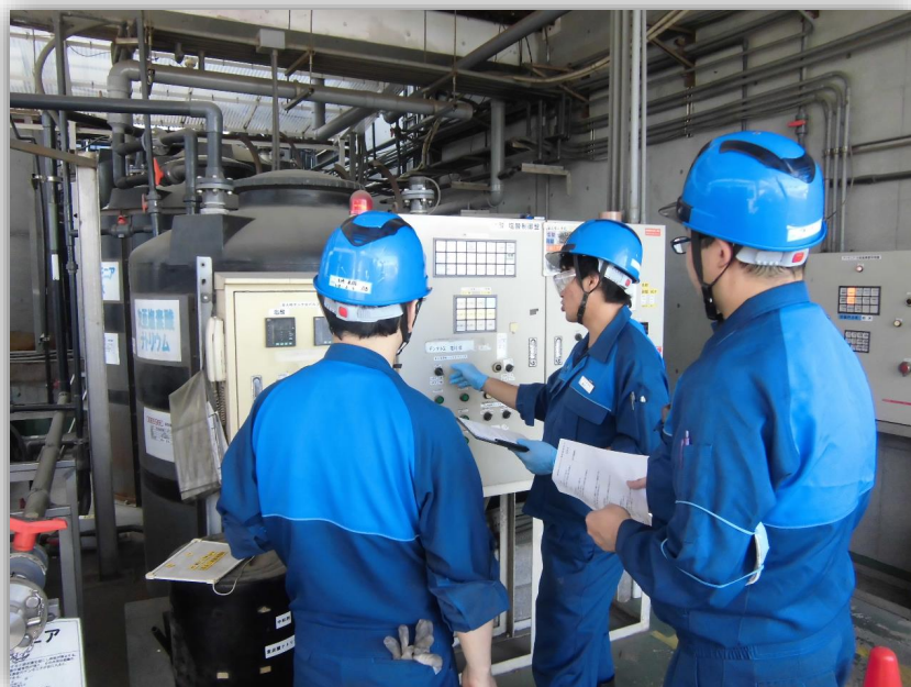
薬液漏洩時の制御盤操作方法
