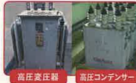
高圧変圧器 高圧コンデンサー
