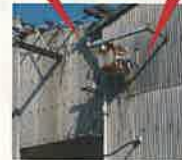
高圧変圧器 高圧コンデンサー
